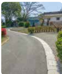
藤岡市発注現場
