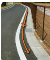
直線から曲線施工
