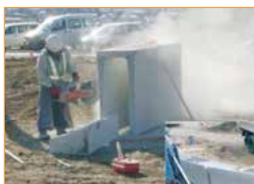
現場カット時の騒音・粉塵が発生
