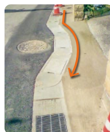
マンホールよけ
