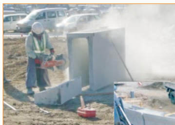
現場カット時の騒音・粉塵が発生
