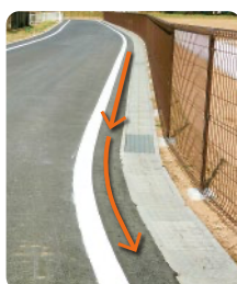
直線から曲線施工
