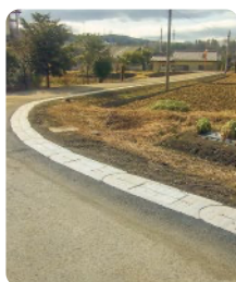
中之条町発注現場
