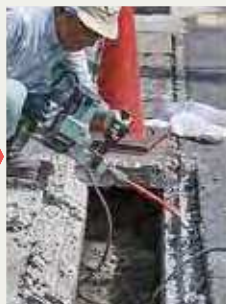
立ち上がり部はつり
