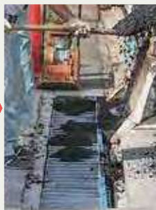
舗装材を敷く
